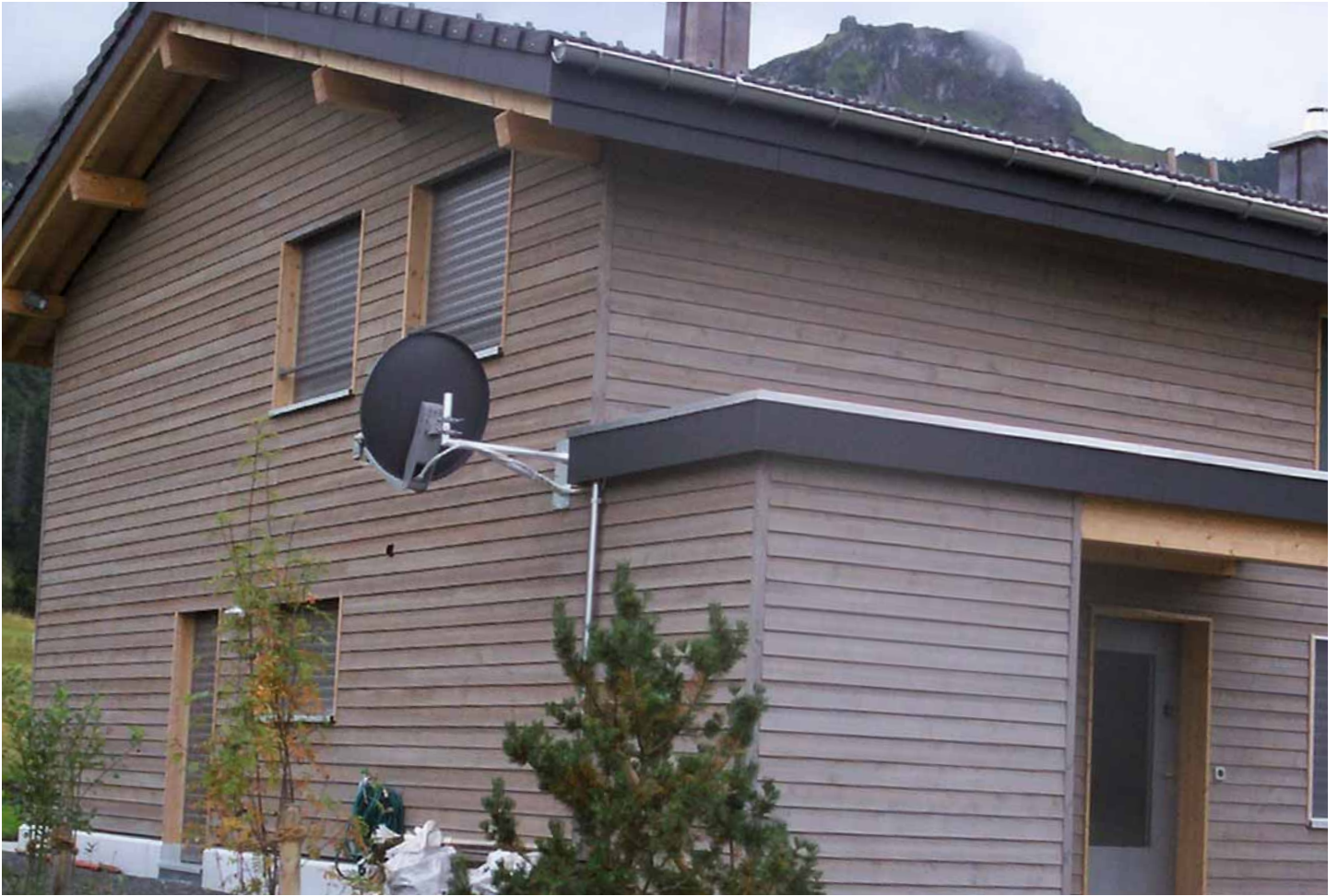
Douglasie, Fassadenprofil, endbehandelt mit Pullex Silverwood
