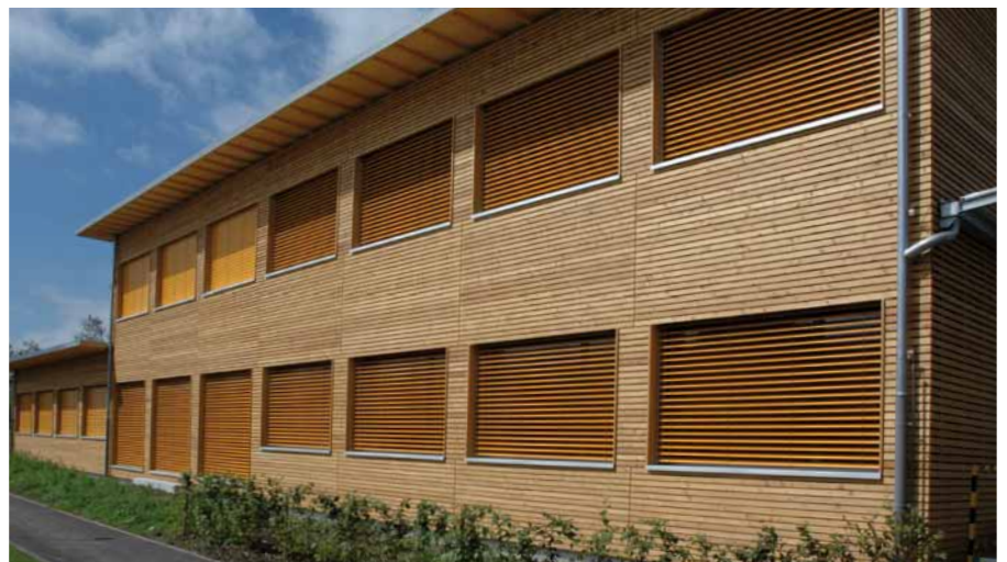
Sibirische Lärche, Rhombusleisten, behandelt mit Protector Plus
