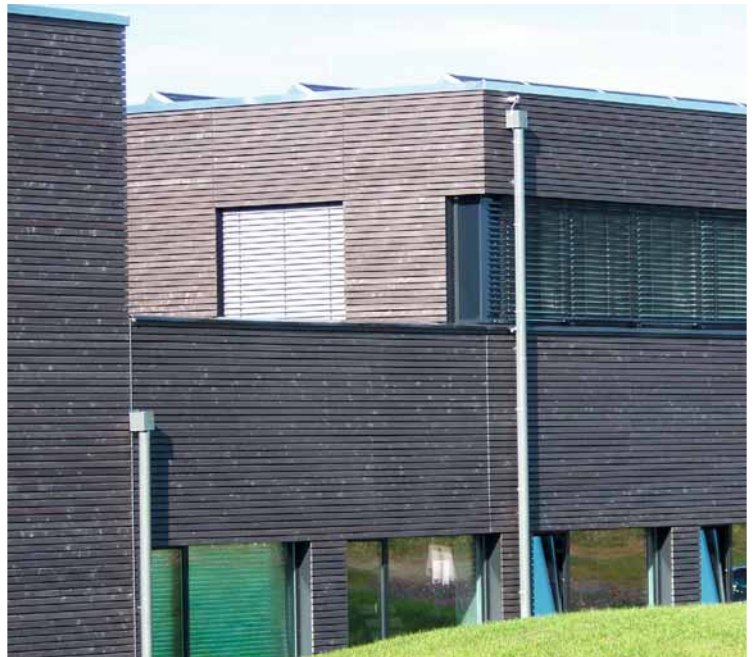
Sibirische Lärche, Rhombusleisten, behandelt mit Silverwood Graualuminium
